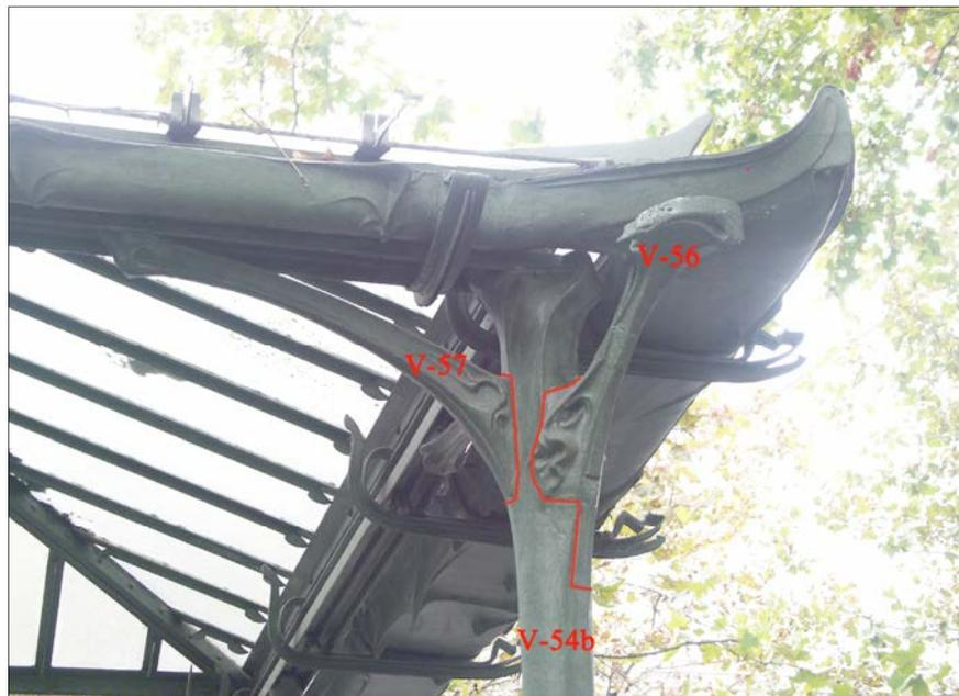
**V-54a.** Édicule A, pilier postérieur droit et gauche, fût. Pas d'écoulement des eaux à la base.
