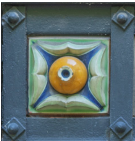
Métope n° 13 d'un linteau de l'hôtel Jassedé (1893) enserré dans des barres de fer vissées.
