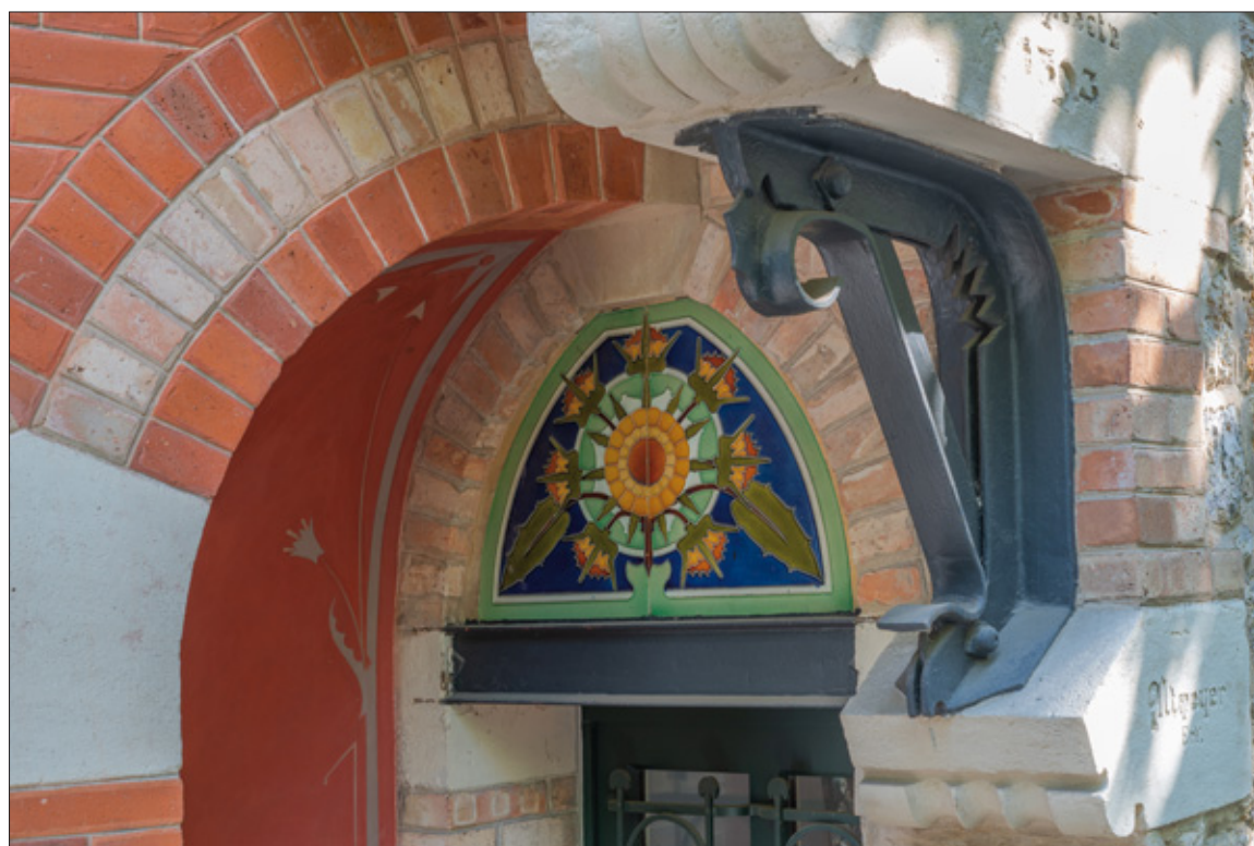
Ci-dessous : tympan de la porte d'entrée principale vers le jardin sur la façade latérale droite. Panneau cloisonné n° 144 en deux éléments. Haut. 55 cm, larg. 1 m, vendu 30 F-or en terre cuite émaillée et 40 F-or en grès émaillé.
