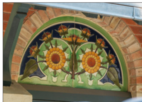
Ci-dessous : tympan de la porte d'entrée principale vers le jardin sur la façade latérale droite. Panneau cloisonné n° 144 en deux éléments. Haut. 55 cm, larg. 1 m, vendu 30 F-or en terre cuite émaillée et 40 F-or en grès émaillé.
