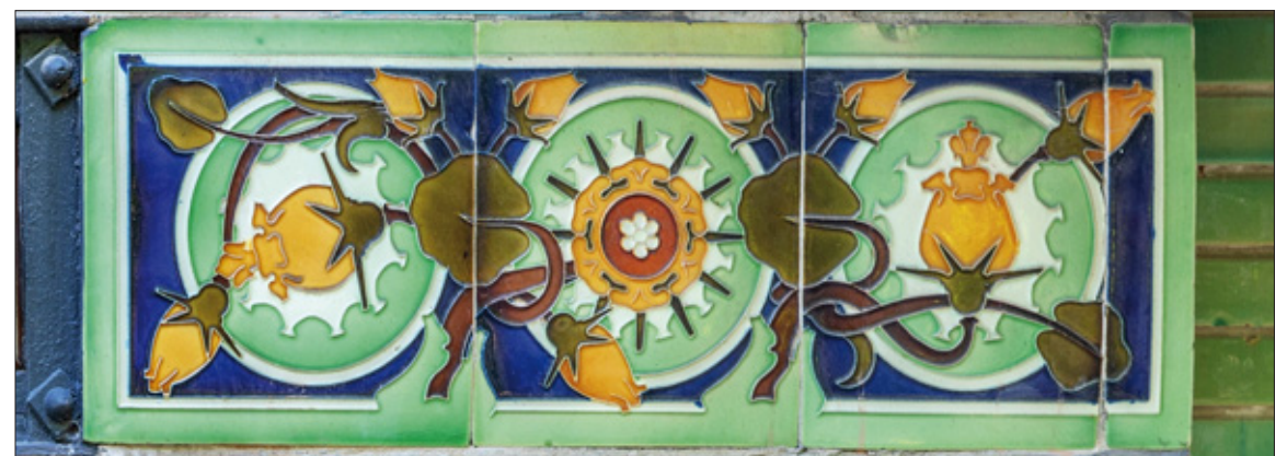
Frise à droite du linteau d'une fenêtre du premier étage de la façade sur rue de l'hôtel Jassedé. L'élément de droite a été légèrement réduit. Panneau cloisonné n° 126, vendu au prix de 25 F-or le mètre linéaire en terre cuite émaillée et 30 F-or en grès émaillé. Haut. 35 cm, larg. des éléments de début et de fin : 35 cm ; larg. d'un élément de milieu : 29 cm.
