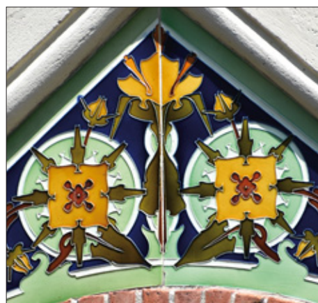
Ci-dessous : tympan de la porte d'entrée principale vers le jardin sur la façade latérale droite. Panneau cloisonné n° 144 en deux éléments. Haut. 55 cm, larg. 1 m, vendu 30 F-or en terre cuite émaillée et 40 F-or en grès émaillé.
