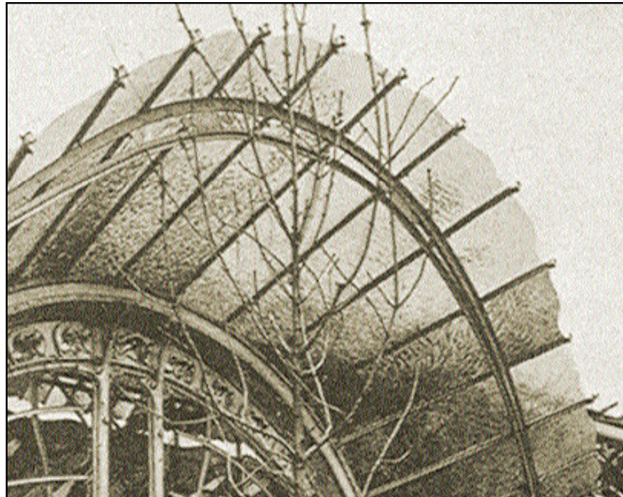
Marquise du pavillon technique de la place de l'Étoile. Cliché ancien.
