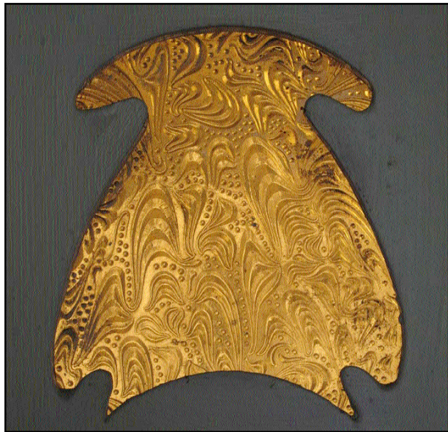
Guimard fait une large utilisation du verre imprimé n° 18 au sein du Chalet blanc qu'il édifie à Sceaux en 1909. Détail d'une porte intérieure, verre jaune. Photo Olivier Bost.
